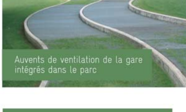
Auvents de ventilation de la gare intégrés dans le parc
