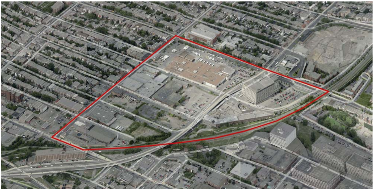
Figure 1 Le secteur Bellechasse. La ligne rouge indique les limites de la zone d'intervention. (Photo aérienne : maps.live.com )
